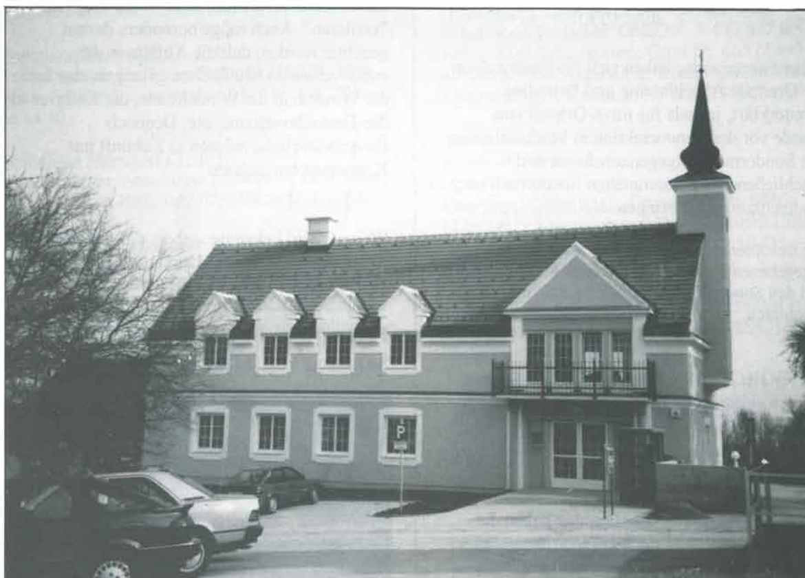
Neuerrichtetes Evangelisches Gemeindezentrum mit Postamt
