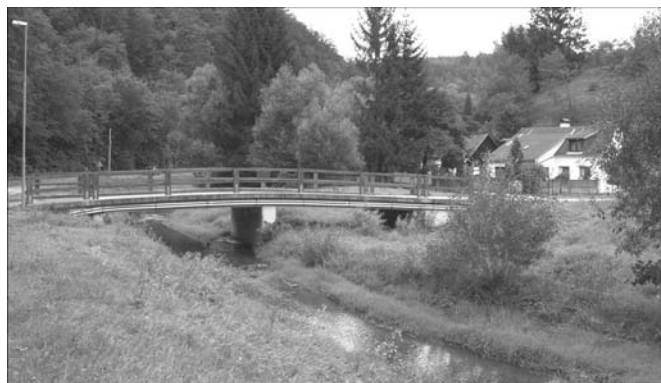
Hochwasserschutz - Stiller Graben
