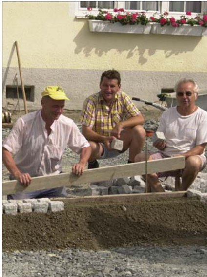
Die Umbauarbeiten schreiten zügig voran
