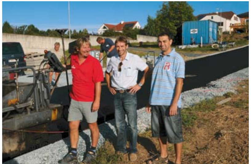
Bauleiter Ing. Wolfgang Hotwagner (re.) gemeinsam mit Thomas Rosner (Mitte) von der Firma Granit bei der Baustellenbesichtigung am Sonnenweg.
