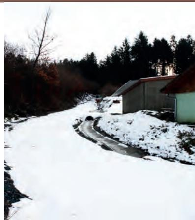
Erfreulich zu erwähnen ist, dass die Arbeiten des Straßenabschnittes zum Wasserbehälter begonnen wurden. Es wurde bereits die Entwässerung gebaut und die Asphaltierungsarbeiten werden nach Wetterlage noch fertiggestellt.
